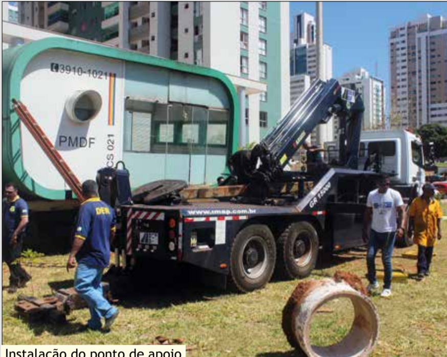
Instalação do ponto de apoio
